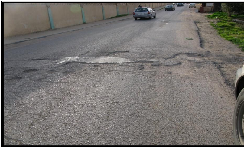
الصورة (12) الحفر نتيجة لتفتت الطبقة العلوية بالطرقات بالمدينة.
