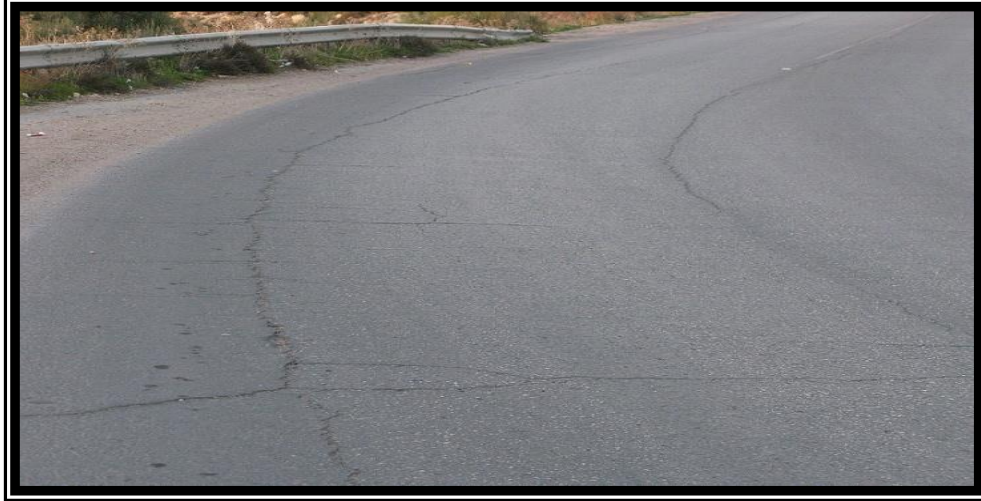
الصورة (11) التشققات الطولية على الطرقات بالمدينة.
