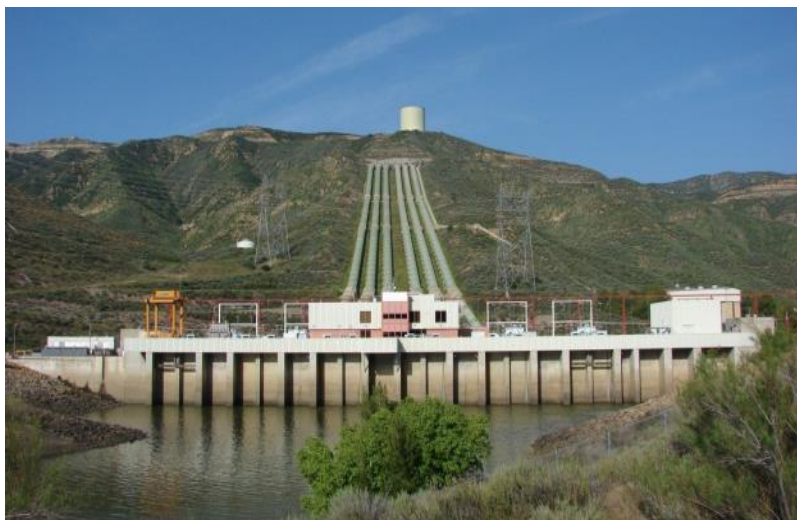
الشكل رقم (4) يوضح أنابيب نقل المياه
