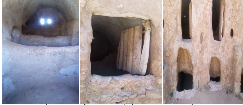
الصورة رقم ( 17 ) توضح الغرف في قصر الحاج مقسمة من الداخل إلى أحواض الصورة رقم ( 18 ) توضح أبواب الغرف في قصر الحاج مصنوعة من جذوع النخيل الصورة رقم ( 19 ) توضح فتحات الغرف والسراديب في قصر الحاج المصدر : تصوير الباحث
